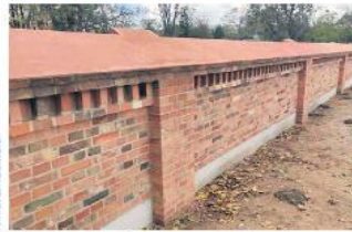
Odbudowę muru zakończono przed 1 listopada
